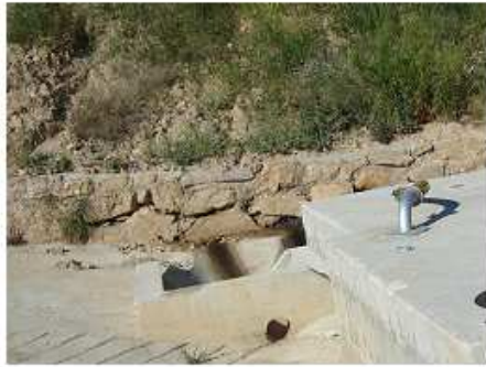
Salidas de lixiviados a través de escollera presuntamente (y pagada) impermeabilizada
